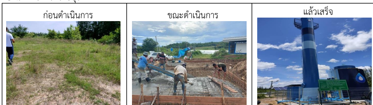
๑๕.โครงการก่อสร้างระบบผลิตน้ำประปา (Water Treatment System) POG ระบบขนาด M รองรับ ๕๑-๑๒๐ครัวเรือน กำลังการผลิต ๗ ลูกบาศก์เมตร/ชั่วโมง บริเวณบ้านหนองตาเล็ก หมู่ที่ ๘ ตำบลหนองพันจันทร์ อำเภอบ้านคา จังหวัดราชบุรี
